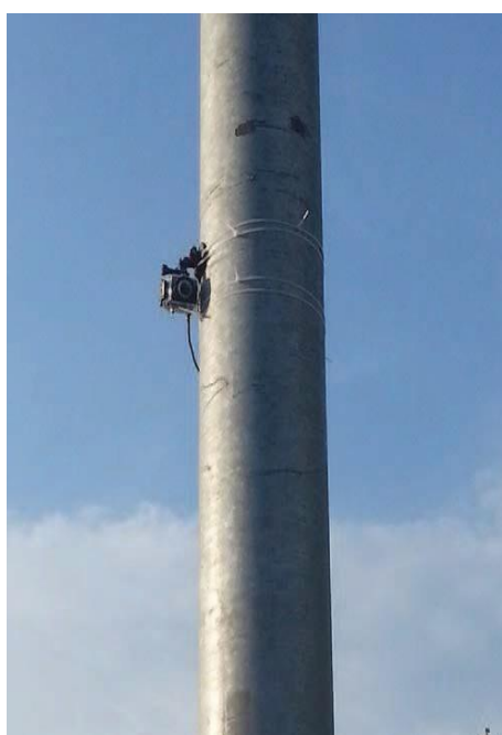
Рисунок 5 – Монтаж видеокамеры на столб линии электроосвещения
